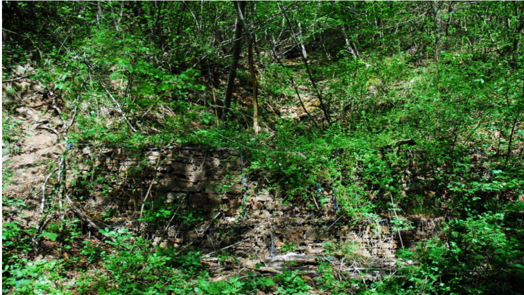
Figura 13. Secondo affluente di destra, particolare della briglia in gabbioni.
