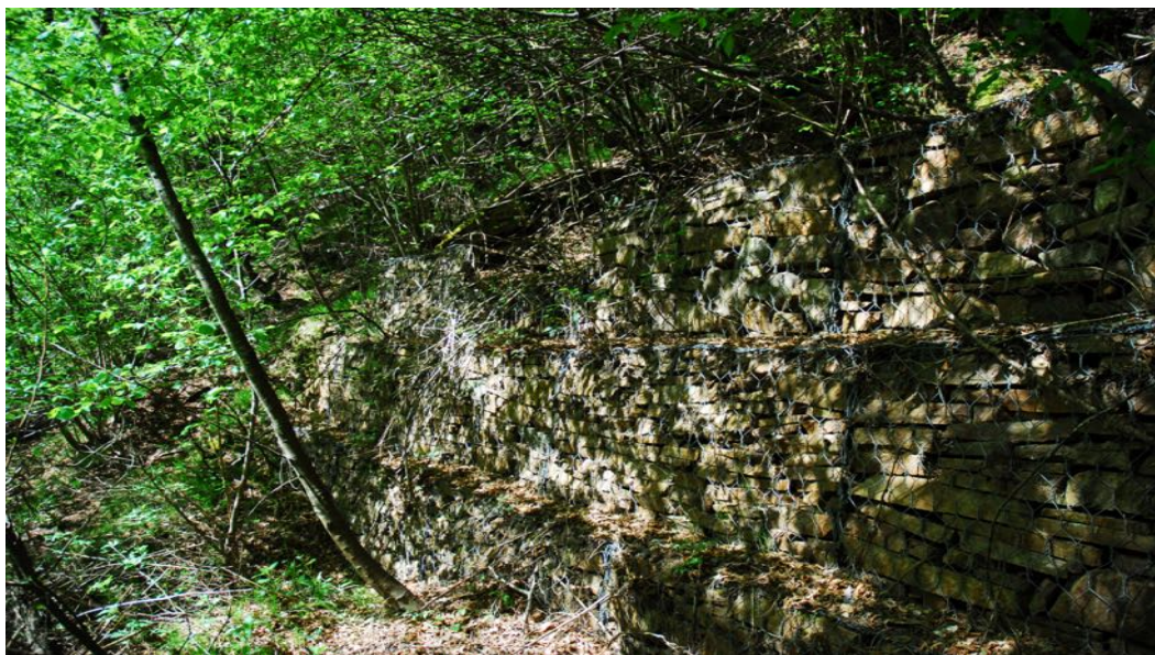
Figura 12. Primo affluente di destra, particolare della briglia in gabbioni.
