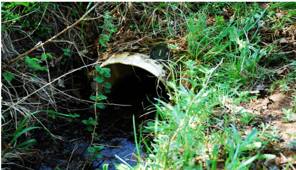
Figura 6. Particolare tubo di drenaggio (diametro 30 cm).
