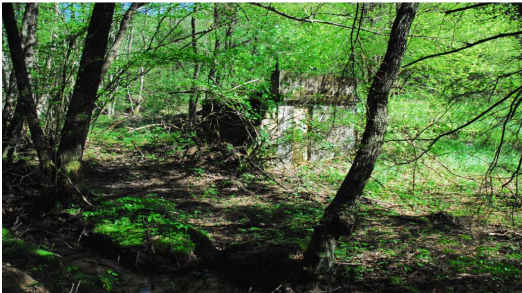
Figura 8. Punto di presa dismesso.
