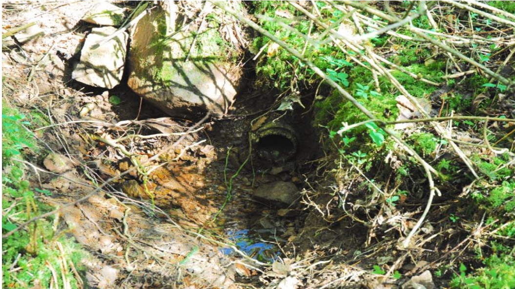
Figura 9. Tubo che collega il punto di presa con il corso d'acqua (diametro di 10 cm).
