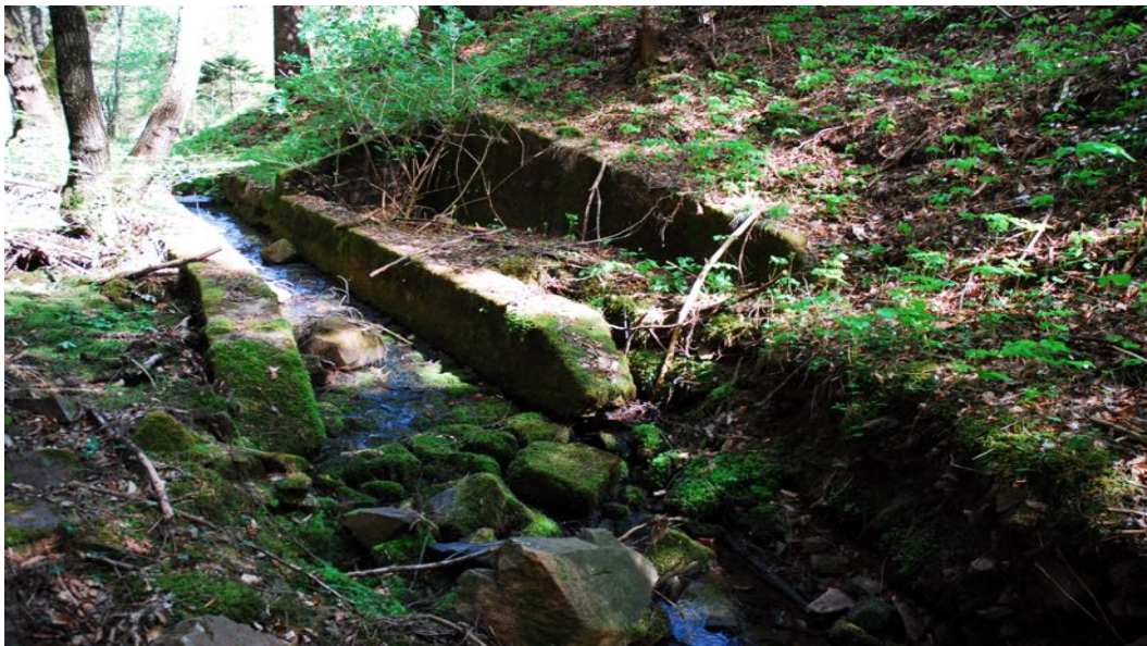
Figura 10. Sorgente amministrativa e vasca di decantazione.
