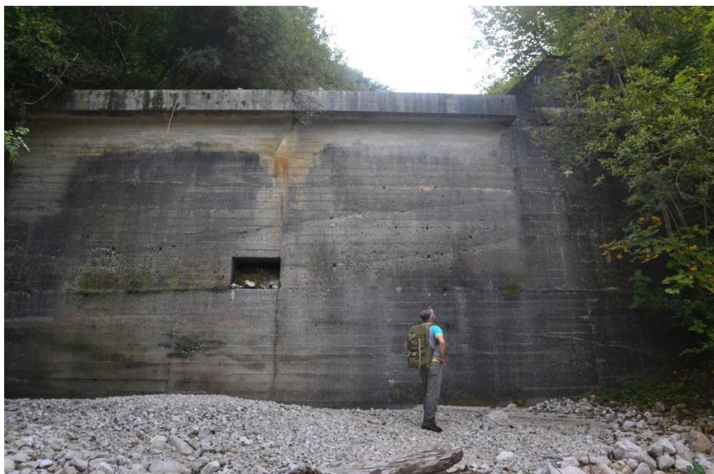
**Figura 7 e Figura 8:** Due grandi briglie in cemento armato realizzate dopo l'alluvione del 1966
