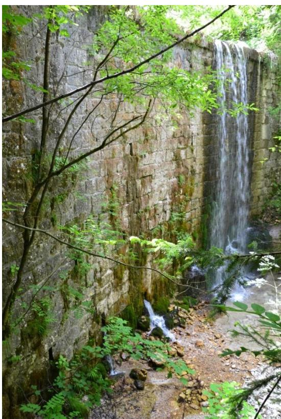
**Figura 11 e Figura 12:** Una grande briglia in pietra costruita dopo l'alluvione del 1924 nel medio tratto del torrente
