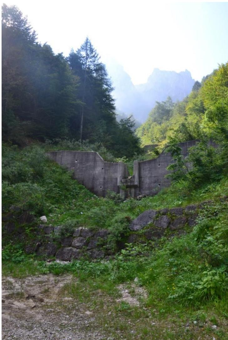
**Figura 1:** Briglie sul ramo della "Val dei Morti" realizzate dopo l'alluvione del 1966
