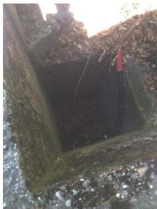
Figura 2.6.2. Imbocco per il passaggio sotto la strada del lago Santo.
