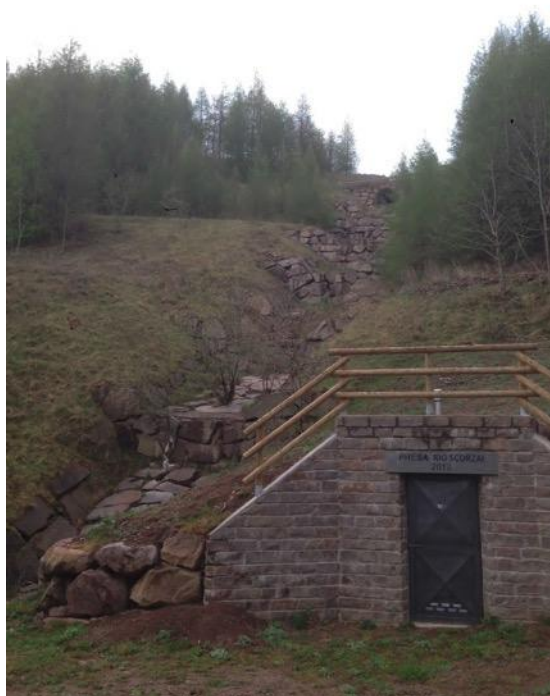
Figura 2.5.3. Vista della briglia e della presa.
