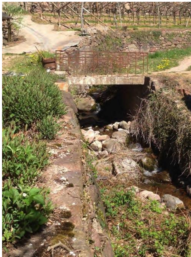
Figura 2.11. Il ponte piccolo.
