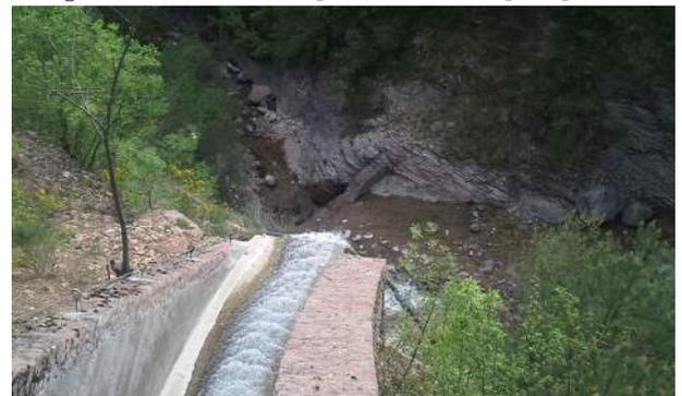
Figura 3.8: Sbocco della condotta nel Rinassico
